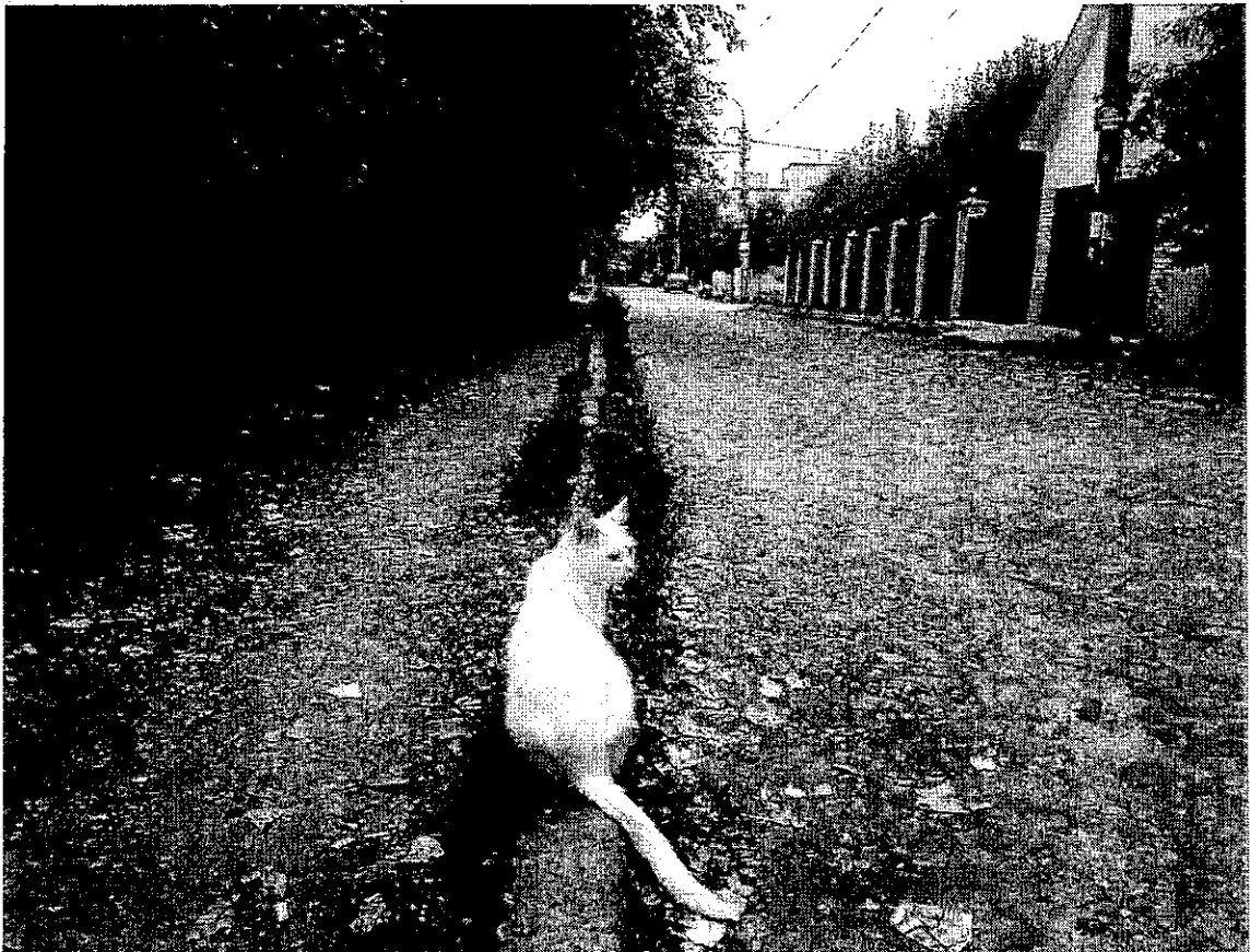
Фото 3. Відсутнє покриття на відріжку вул. Маршальська вздовж паркану будинку №21
