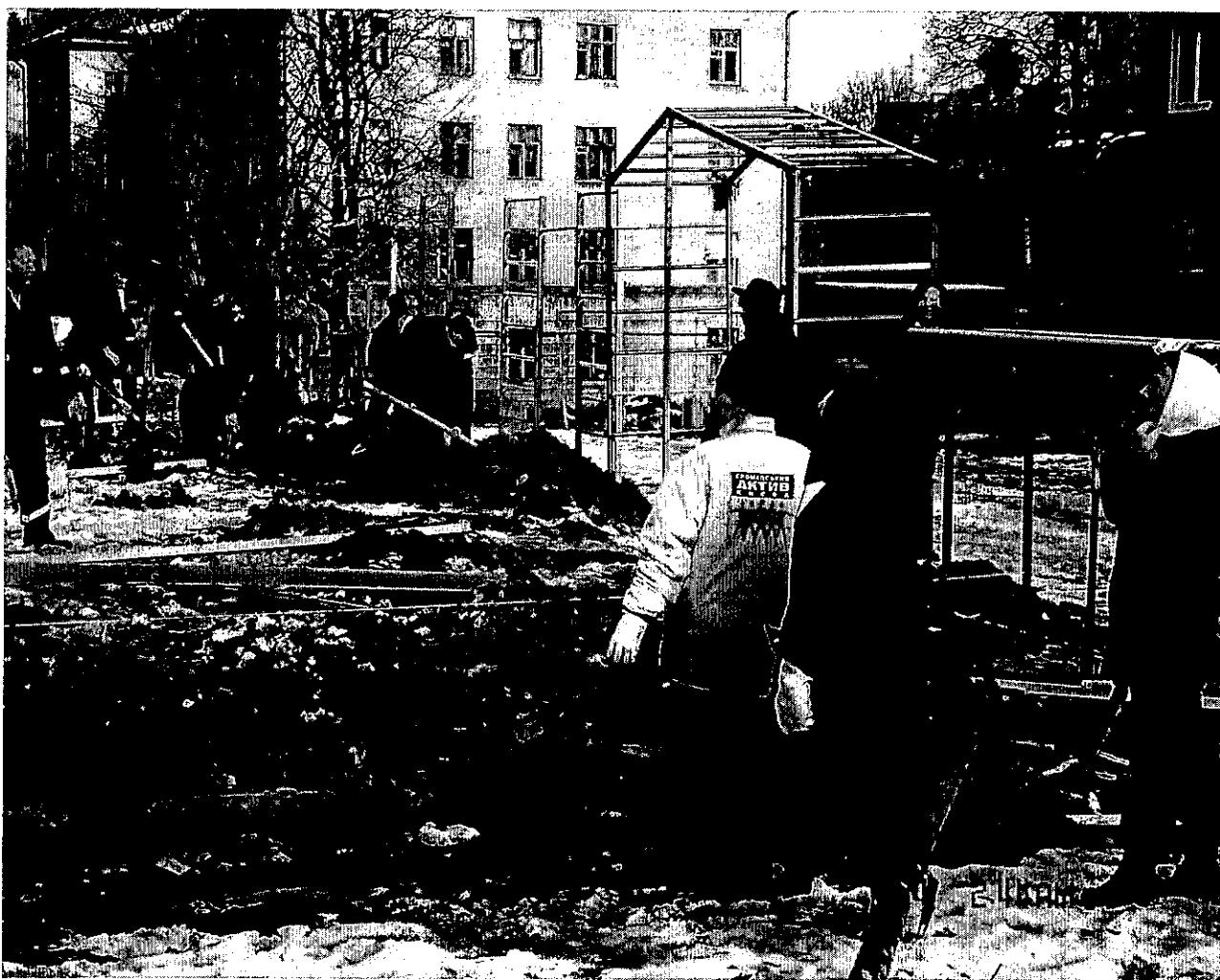
Фото 10: видовбування вручну в фундаменті колишньої споруди ДСО “Авангард” ямок під огорожі футбольного поля, 23 – 24.11.2007
