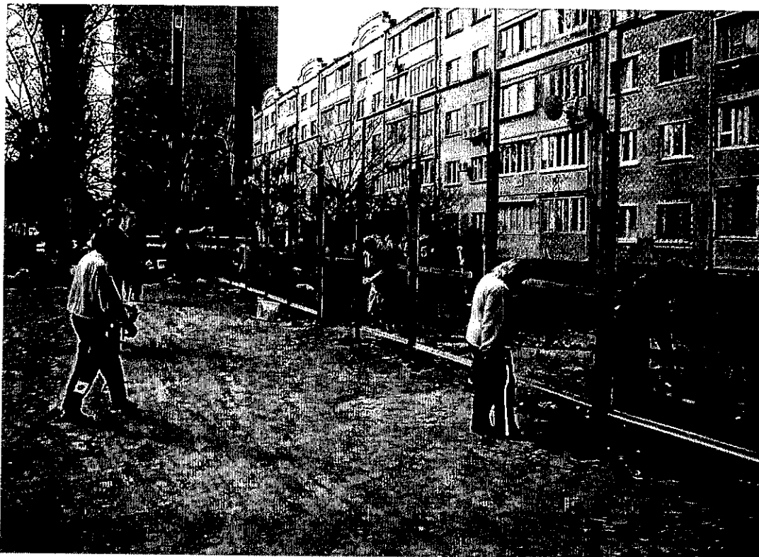
Фото 15: облаштування покриття футбольного поля, 15.04.2008
